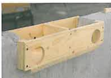
Nistquartiere (Rohbau): in Balkonbrüstung eines Wohnhauses.
