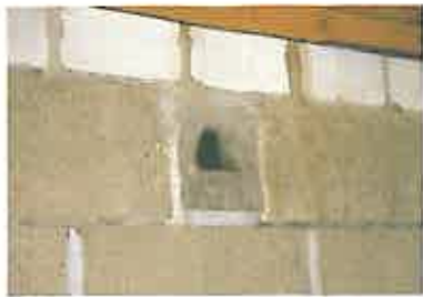
Niststein im Rohbau: einfach eingebaut
