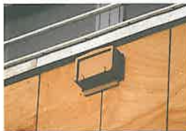
Spezialnistkasten fertig verkleidet: Terrassenbrüstung des Bürogebäudes, Fertigansicht.
