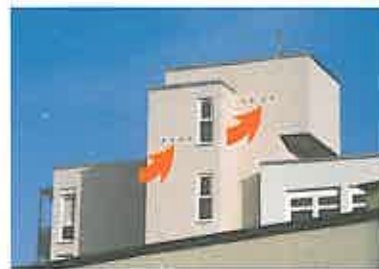
Mauersegler-Niststeine: in Wohn- und Geschäftshaus.
