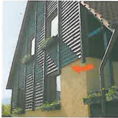
Sommerquartier für Fledermäuse: Holzverschalungen und Faserzementverkleidungen an Hauswänden eignen sich besonders gut.
