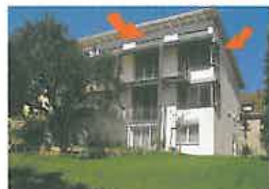
Integrierte Nistkästen: Unter dem Dachüberstand wurden unsichtbar Nistmöglichkeiten geschaffen.
